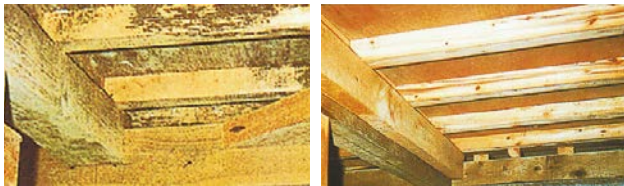
A 床下換気扇を設置していない床下
